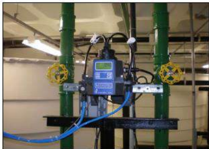
Figura 3 – Automação (Turbidímetro on-line)
