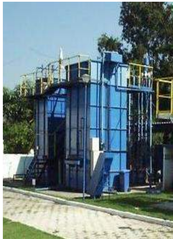
UASB seguido de Biofiltro Aeróbio (UFES)
